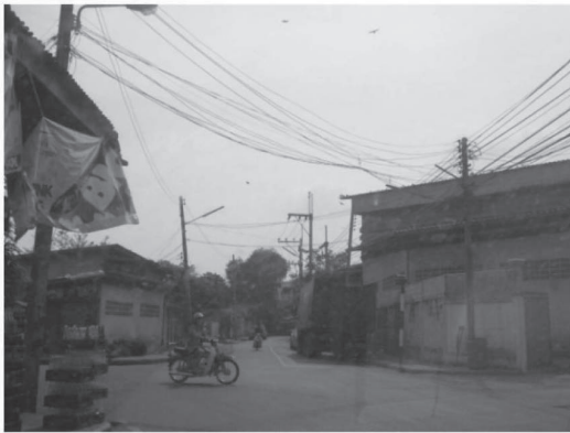
รูปที่ P3b - 1 แสดงภาพของทางแยกที่มีระยะมองเห็นปลอดภัยไม่เพียงพอ
