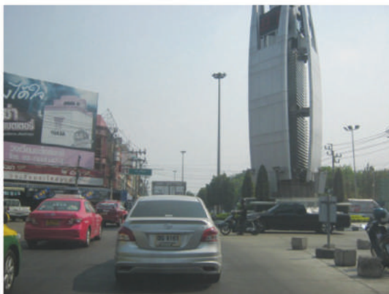
รูปที่ M7a-1 แสดงภาพปัญหาขาดการติดตั้งสัญญาณจราจรและเครื่องหมายบนผิวทาง
