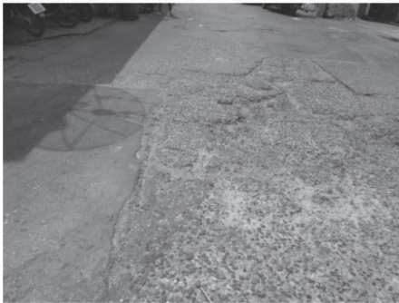
รูปที่ P1c - 2 ผิวทาง/ไหล่ทางชำรุด ขรุขระ เป็นหลุมเป็นบ่อ
