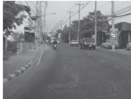
รูปที่ P1c - 2 ผิวทาง/ไหล่ทางชำรุด ขรุขระ เป็นหลุมเป็นบ่อ
