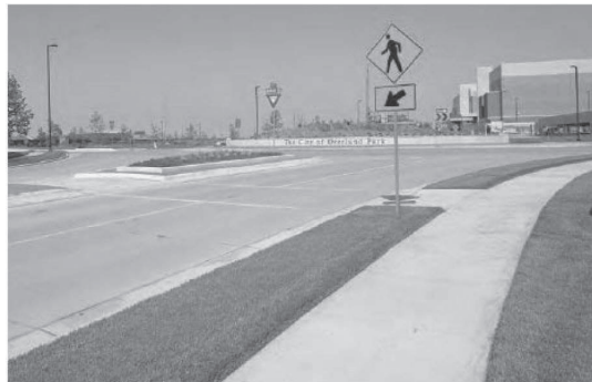
รูปที่ P8b - 2 การติดตั้งเส้นทางคนข้ามและทางเดินเท้าบริเวณวงเวียน
