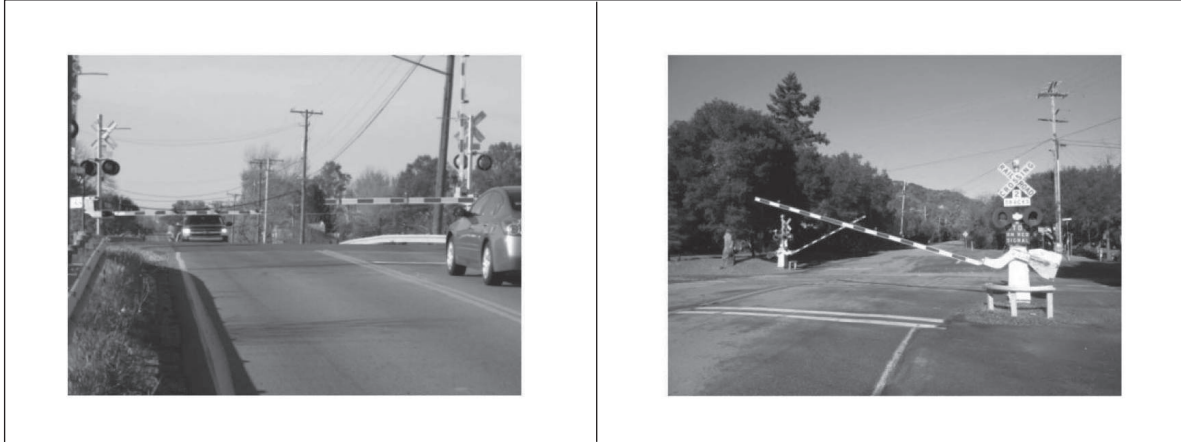
รูปที่ S3d-3 ตัวอย่างการติดตั้งเครื่องกั้นที่ได้มาตรฐาน
