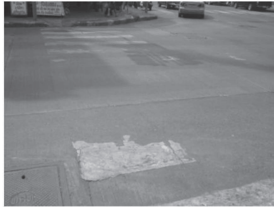
รูปที่ P7b - 1 เส้นทางคนข้ามไม่ชัดเจน ชำรุด และไม่ได้มาตรฐาน
