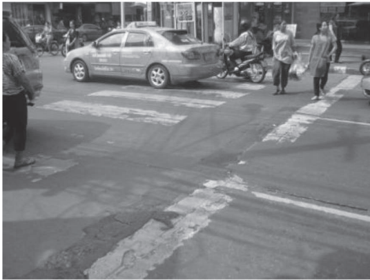
รูปที่ P7b - 1 เส้นทางคนข้ามไม่ชัดเจน ชำรุด และไม่ได้มาตรฐาน
