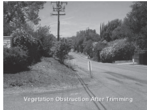
รูปที่ P3b - 2 แสดงภาพการตัดต้นไม้ที่กีดขวางการมองเห็นบริเวณทางแยก
